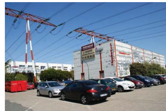
Illustration 8. Ligne THT à l'ouest de la parcelle principale
